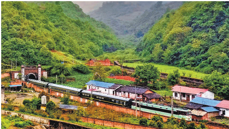
四川省凉山彝族自治州喜德县，一列火车通过成昆铁路沙马拉达隧道。 宋豪新 熊 笠摄影报道
