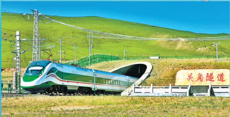
复兴号动车组列车驶出位于青海省海西蒙古族藏族自治州天峻县的青藏铁路新关角隧道。 贾丰丰 周悦翔摄影报道
