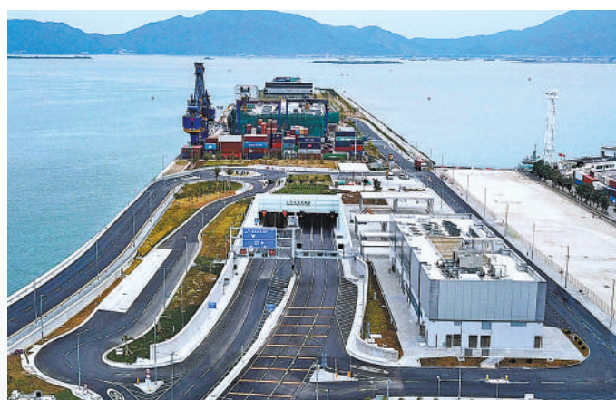
香港屯门至赤鱓角隧道。 香港特区政府路政署供图
