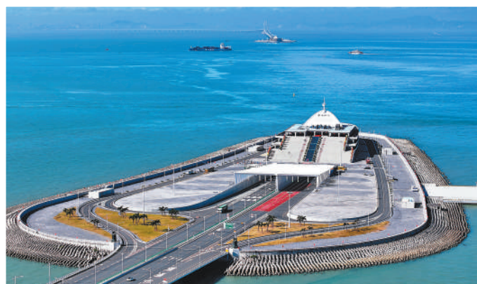
车辆在港珠澳大桥东人工岛驶出海底隧道。 新华社记者 刘大伟摄
