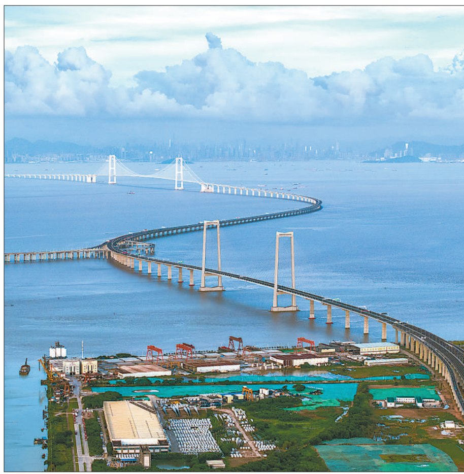
全长约24公里的深中通道跨越伶仃洋，集“桥、岛、隧、水下互通”于一体（拍摄于6月27日）。
