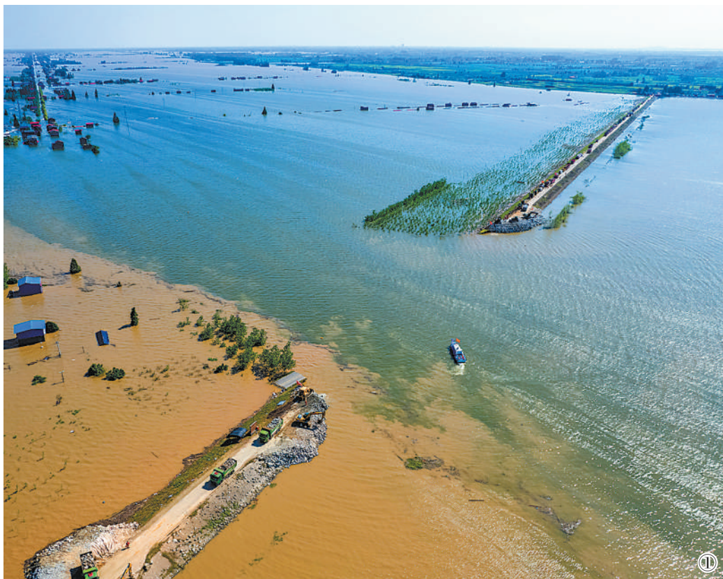
图①：7月6日，在湖南省岳阳市华容县团洲垸洞庭湖一线堤防决口现场，抢险队伍进行堵口作业。新华社记者 陈思汗摄
