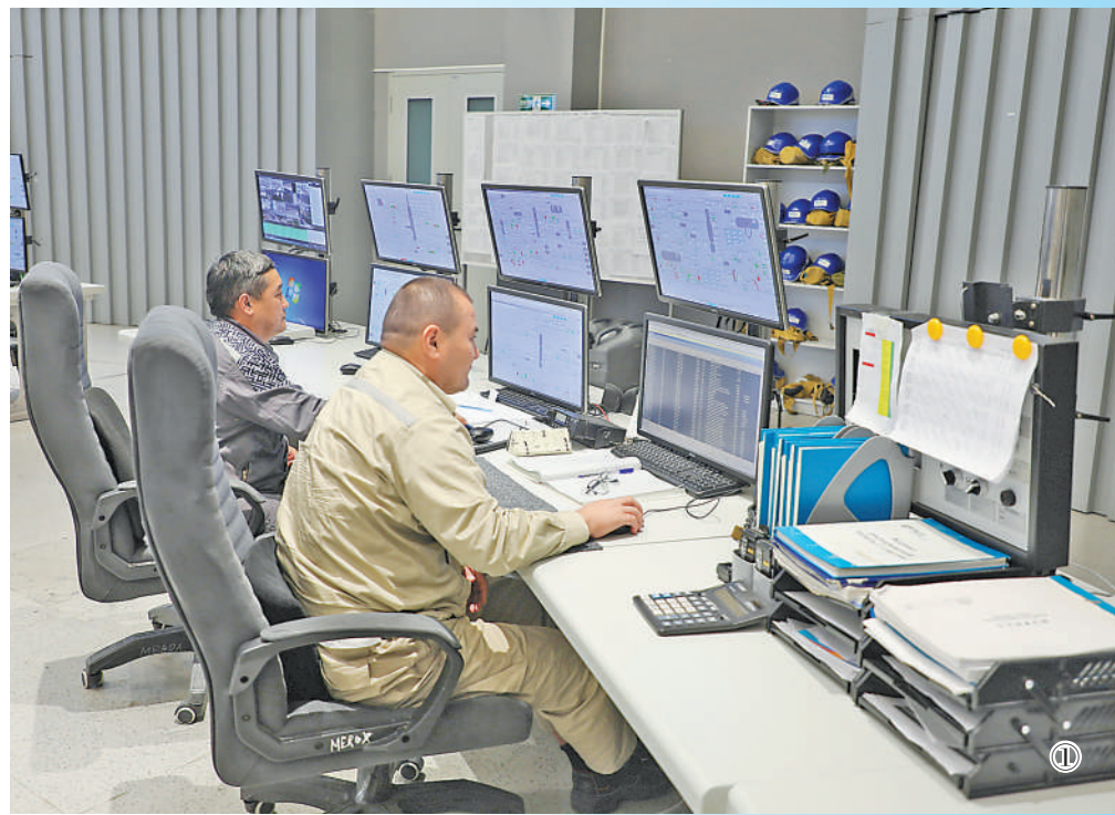
图①：在奇姆肯特炼厂中控室内，操作员正在监控装置运行参数。 本报记者 谢亚宏摄
