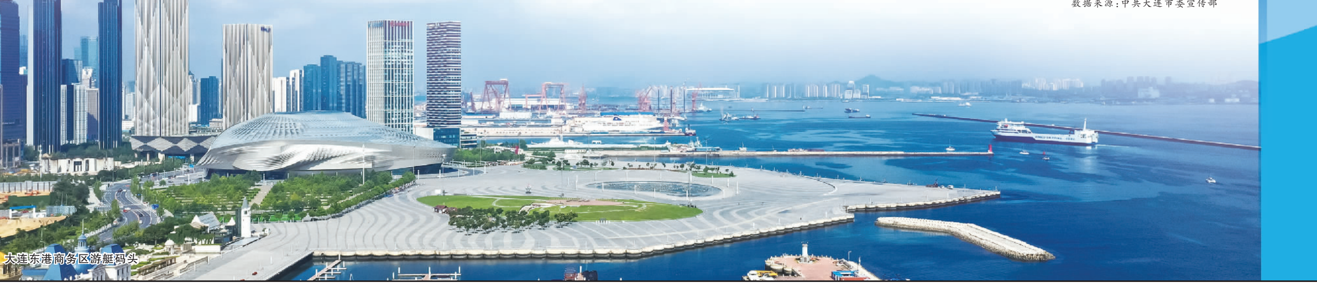
大连东港商务区跨海码头
