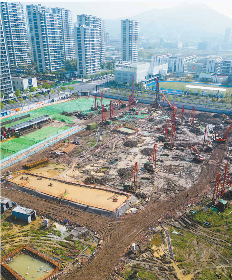
上图：浙江杭州拱墅区桃源单元保障性住房项目建设现场。
