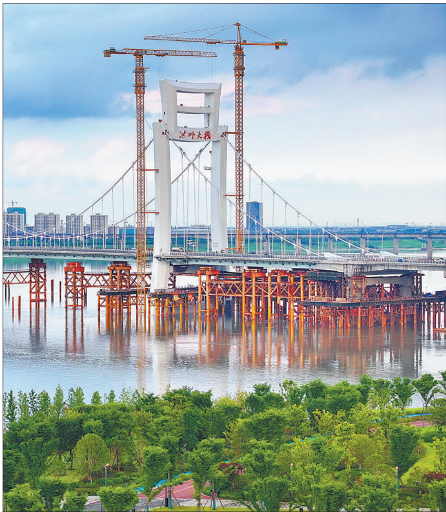
洪州大桥横跨赣江，建成后将成为江西南昌市南部重要的客货运交通快速通道。图为洪州大桥项目建设现场。
