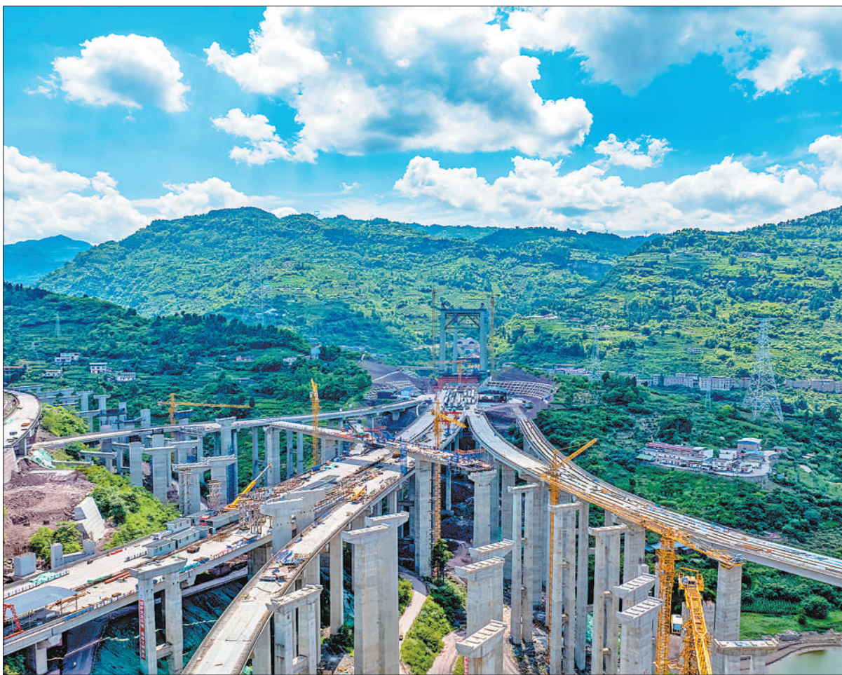
6月17日，四川省宜宾市屏山县新市镇，沿江高速宜全段杨柳坝互通工程现场，施工团队抢抓工期全力施工，确保整个项目如期完工。
