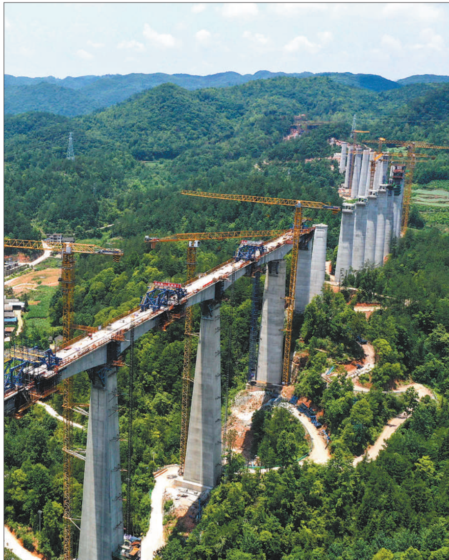
瓮马铁路是贵州省黔南布依族苗族自治州磷矿石、硅石、化肥、煤炭等多种货物集运的重要通道。图为瓮马铁路延长线泥洞司特大桥建设现场。
