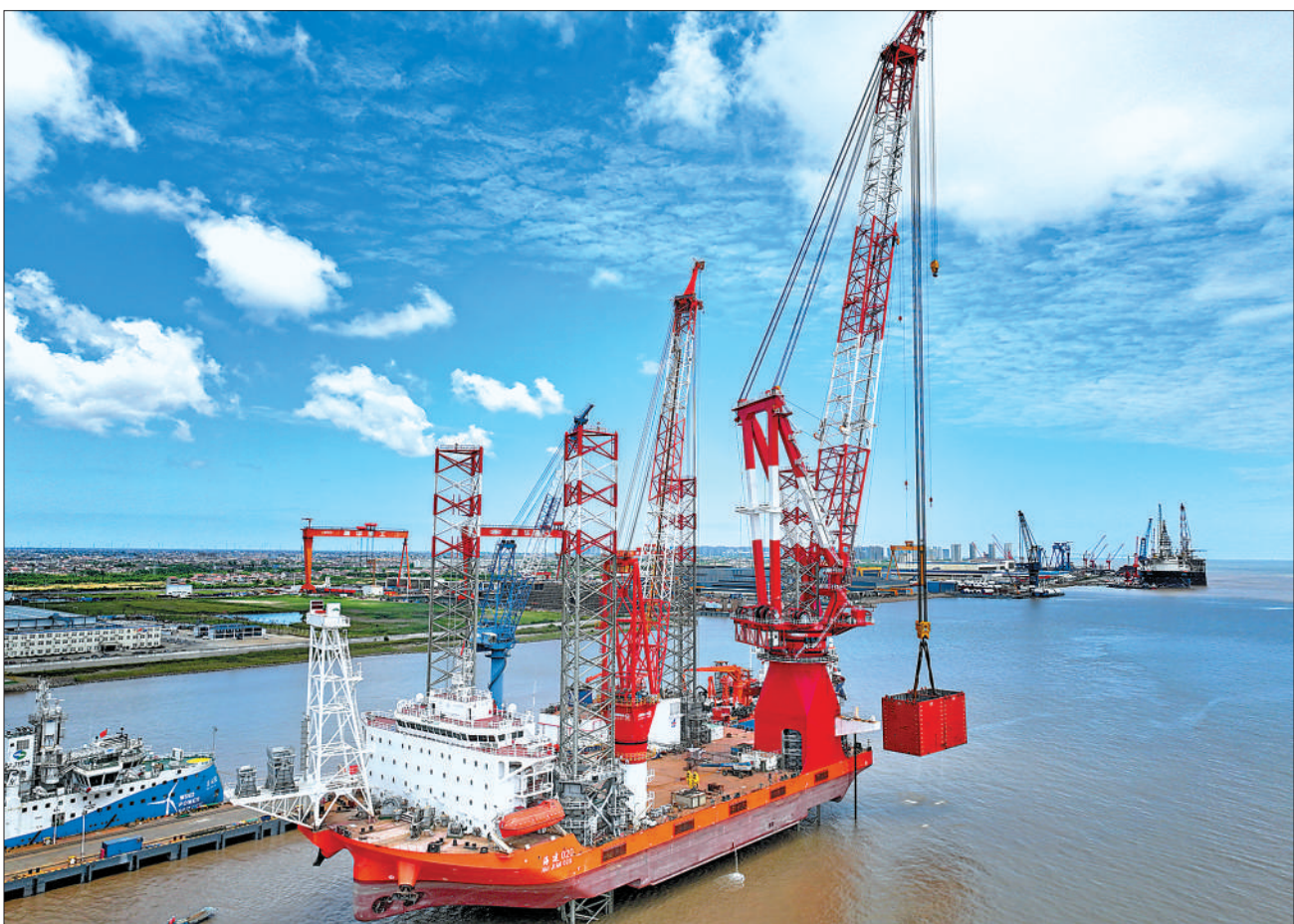
6月6日，我国自主研发设计、具有完全自主知识产权的1600吨自航自升式风电安装平台“海建020”进行1.1倍（1760吨）超载实验，1600吨吊机旋转360度，历时5个小时，圆满完成实验。该平台由振华重工为海建新能源建造。许丛军摄（人民视觉）
