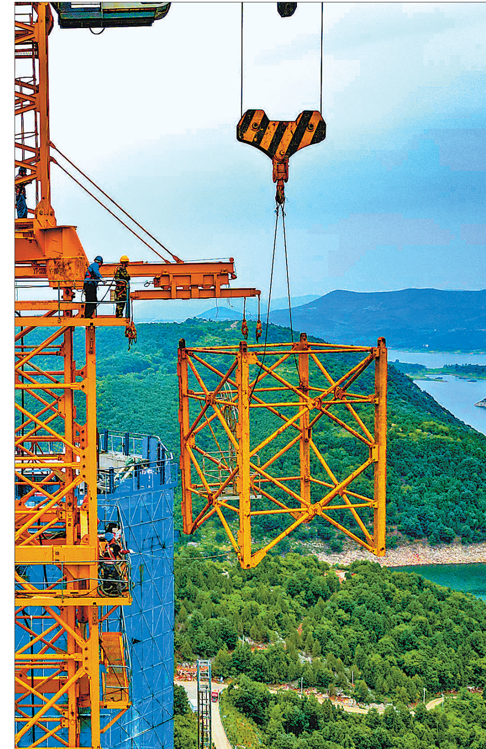
6月4日，河南淅南（池池一浙川）高速丹江小三峡特大桥南主塔正在紧张施工，大桥主塔正式进入封顶施工阶段。丹江小三峡特大桥位于南水北调中线工程水源地丹江口水库库区，是国内跨径最大的跨峡谷分离式混合梁斜拉桥，同时也是河南省第一大跨径斜拉桥。
