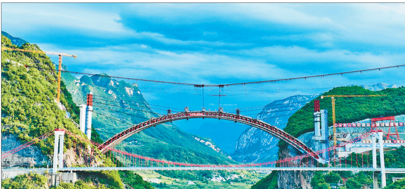
5月27日,贵州省纳雍县至晴隆县高速公路乌蒙山大桥双幅主拱圈顺利合龙,乌蒙山大桥总体施工进度超过七成,建设进入全面冲刺阶段。图为建设中的乌蒙山大桥。刘青摄(人民视觉)
