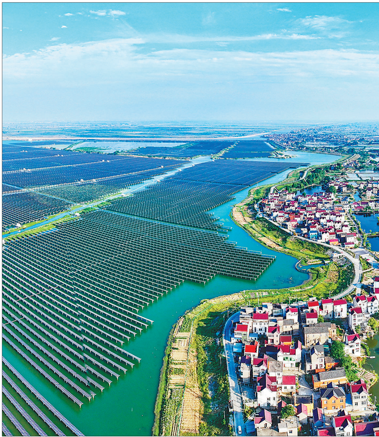
近年来,安徽省马鞍山市当涂县大力发展渔光互补太阳能光伏发电新能源产业,将清洁电能用于生产,助力乡村振兴。图为日前拍摄的当涂县大陇镇双潭渔光互补光伏电站。
