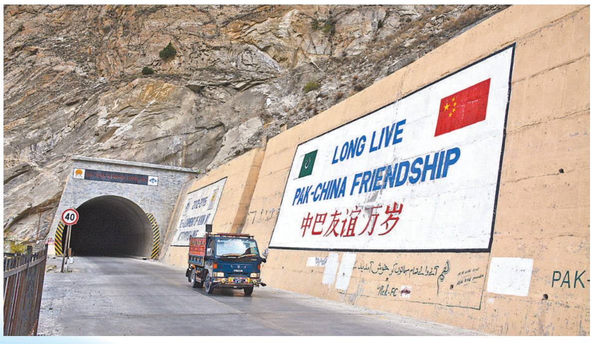
▲喀喇昆仑公路穿越巍峨险峻的喀喇昆仑山脉，大量路段位于高寒山地，地质条件复杂，修建桥梁和隧道的工程难度大、危险性高。公路沿线有多处巴方设立的纪念地标，传承两国友谊。图为汽车行驶在喀喇昆仑公路上。 本报巴基斯坦分社 赛义德·迈赫迪摄
