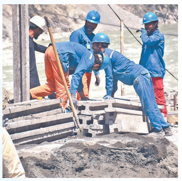
►为保障喀喇昆仑公路畅通，巴中两国工程技术人员正在进行施工。 本报巴基斯坦分社 赛义德·迈赫迪摄
