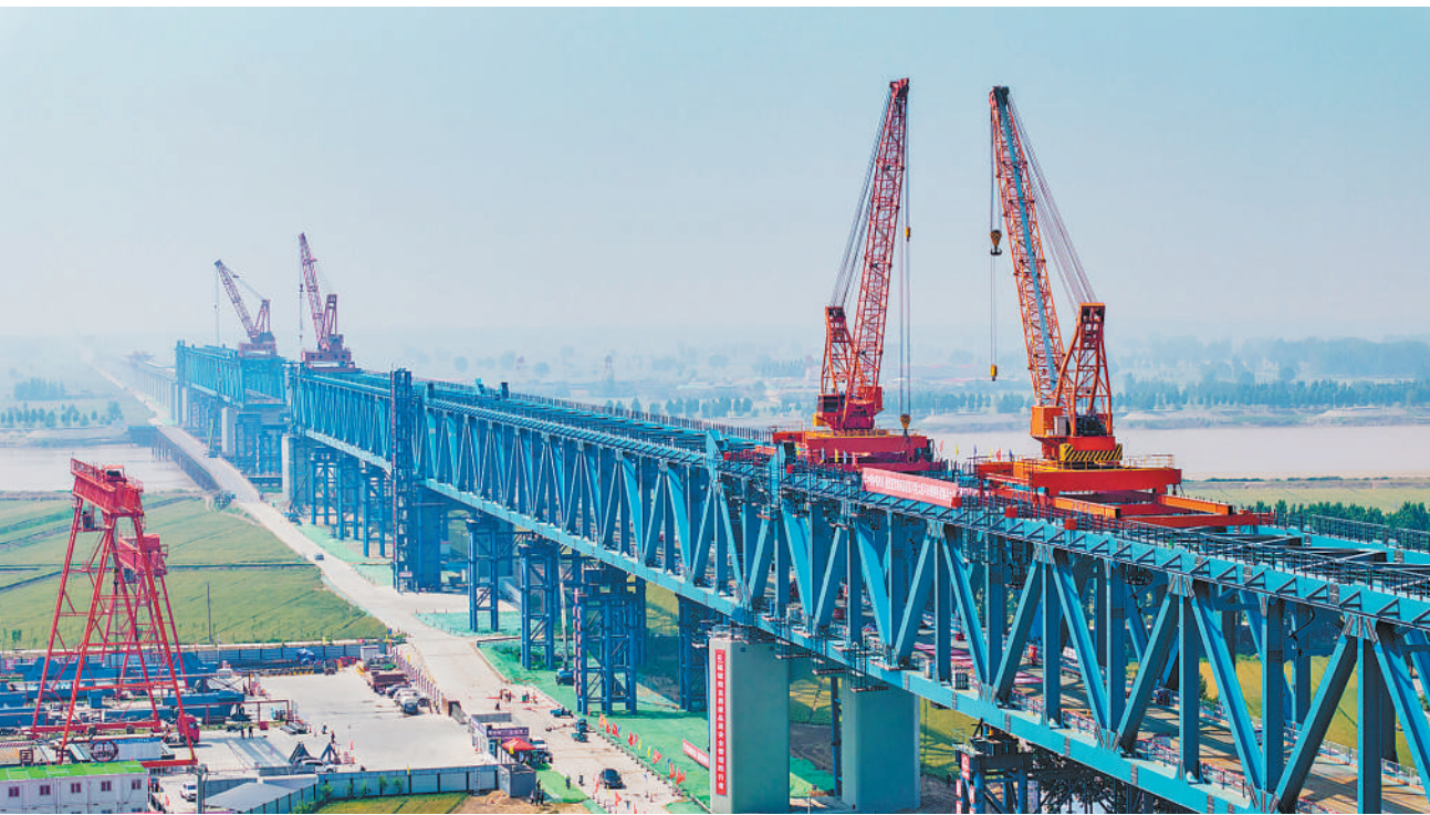
5月18日，雄(安)商(丘)高速铁路黄河特大桥主桥河南侧合龙，为后续全桥贯通及拱肋安装提升打下坚实基础。雄商高铁是我国“八纵八横”高速铁路网的重要组成部分，也是中部地区南北向铁路旅客运输的主通道。雄商高铁黄河特大桥主桥总长1600米，是雄商高铁项目重要控制性工程之一。图为雄商高铁黄河特大桥主桥河南侧施工现场。刘玉才摄(影像中国)
