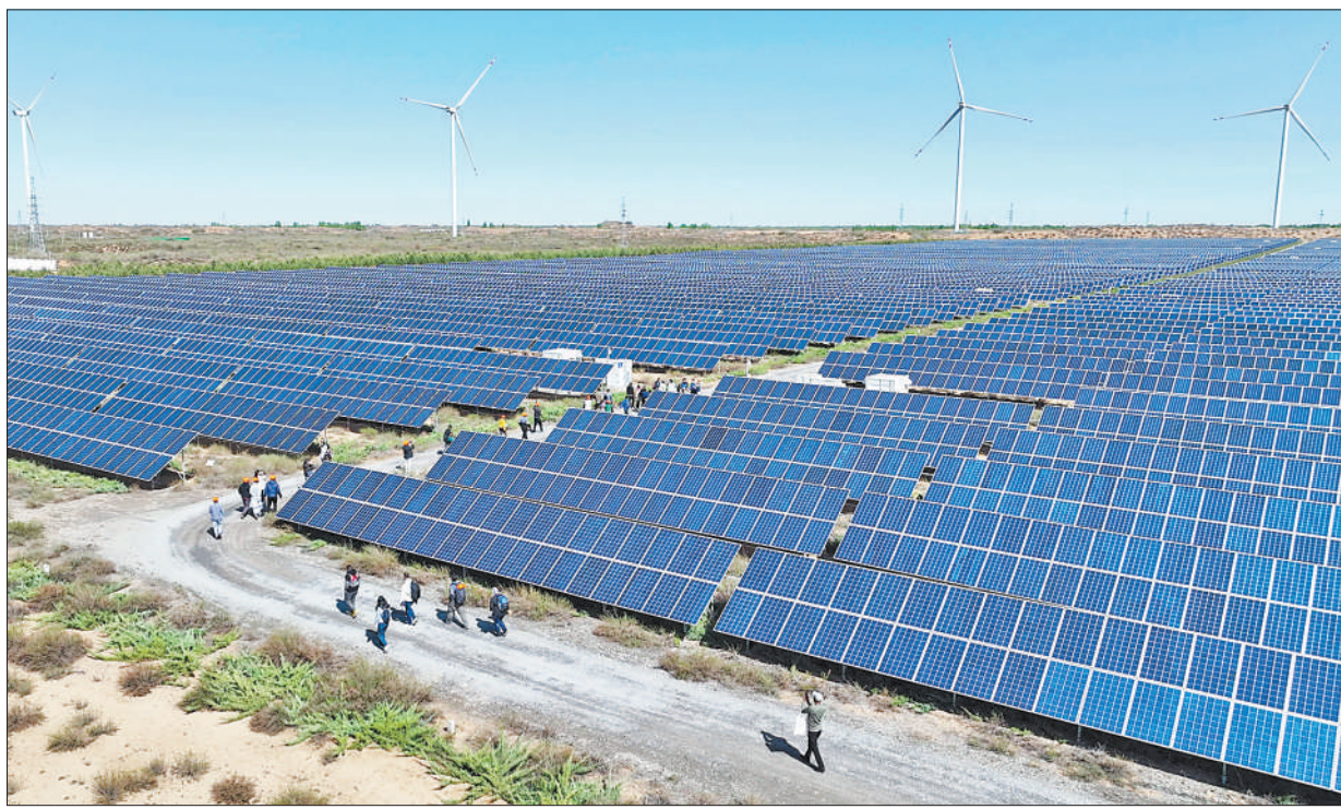
研修班学员参观学习光伏治沙模式,走访位于陕西省榆林市榆阳区的小壕兔光伏项目。 马 腾 摄
