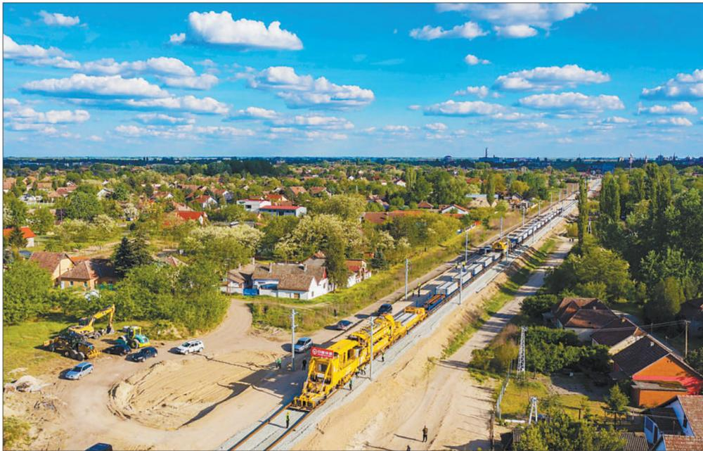
在匈塞铁路项目现场，铺轨机正在塞尔维亚边境的苏博蒂察进行铺轨作业。
