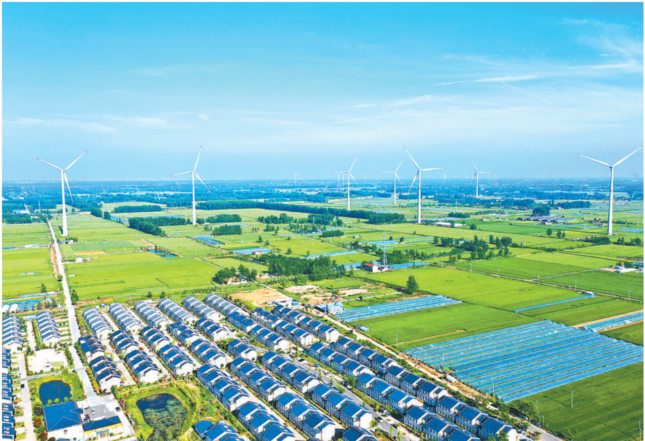
江苏省睢宁县积极发展清洁能源产业，多个风力发电和光伏发电项目投入运行，有力促进当地经济发展，提升能源供给保障能力。图为睢宁县魏集镇，风力发电机组与村居、农田相映成趣。洪星摄（影像中国）
