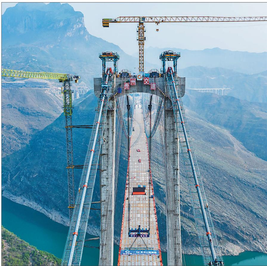
本报北京4月28日电（记者李心萍）记者从中国中铁工业旗下中铁科工获悉：28日，纳（雍）晴（隆）高速群纳大桥顺利合龙。据介绍，群纳大桥位于贵州省晴隆县和普安县交界处，全长1849米，主跨长度1080米，是一座钢桁梁悬索桥。大桥桥面至江面最高距离为380米。图为群纳大桥施工现场。新华社记者 陶亮摄
