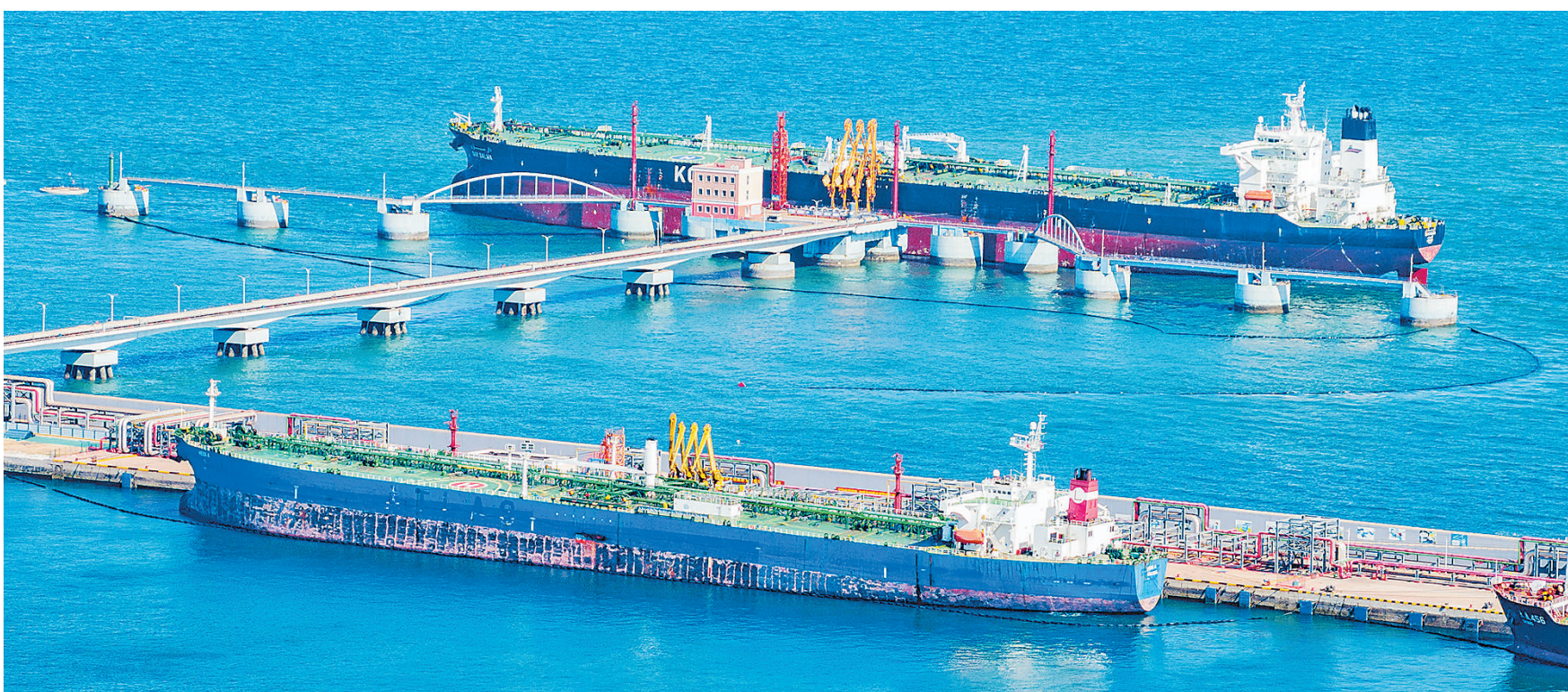
4月26日，山东港口集团青岛港董家口港区原油码头，原油运送船正在接卸原油。
