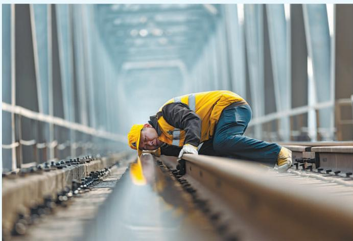
目视前方，行走在东黄河大桥上，顿麒紧握着检查锤，不时敲击着高强螺栓。
