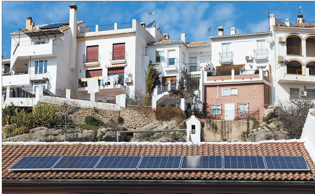
欧盟正在实施“屋顶太阳能计划”,分阶段在新建公共和商业建筑、住宅安装太阳能电池板。图为西班牙龙达市安装在居民住宅屋顶的太阳能电池板。 乔恩·纳斯卡摄(新华社发)
