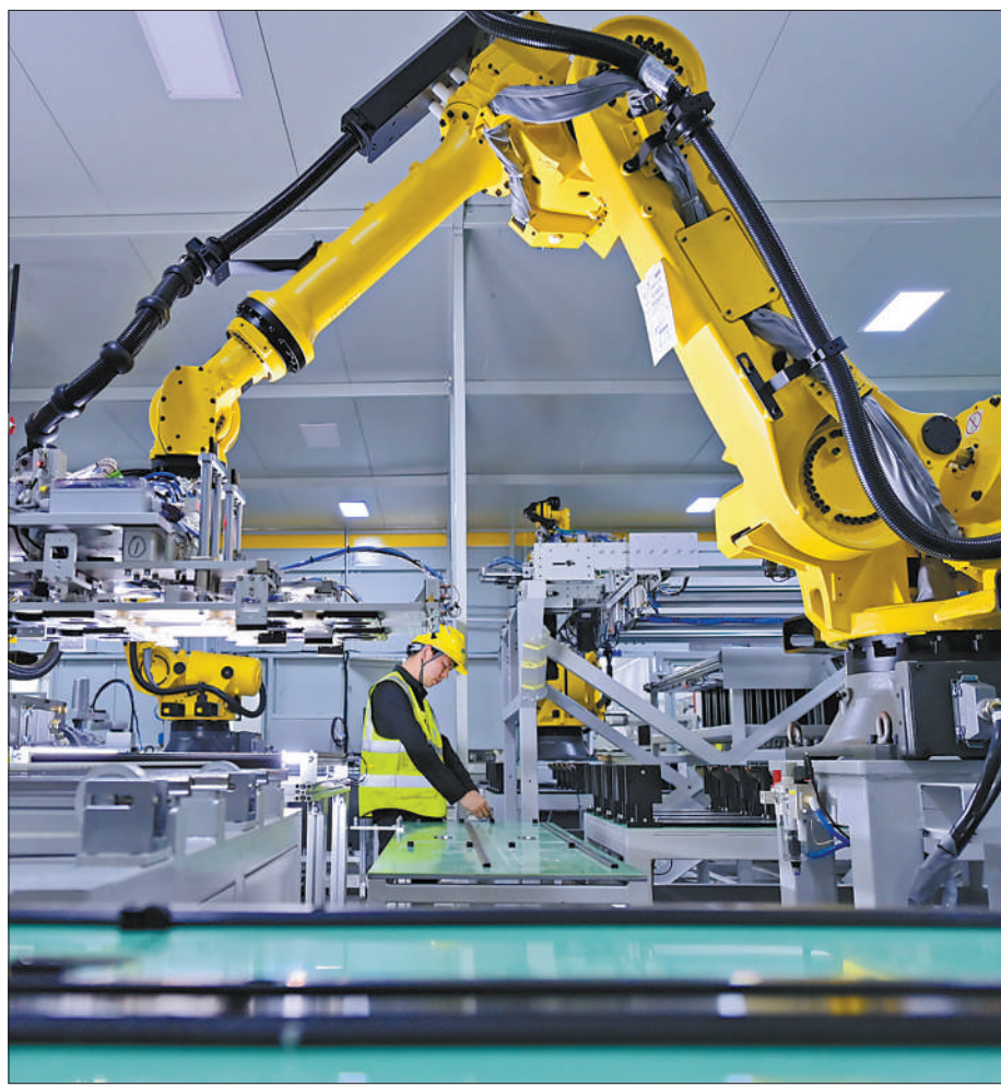
江西赣州经开区新能源科技城一家动力电池生产企业,技术人员在调试新安装的智能机械臂和自动化生产设备。
