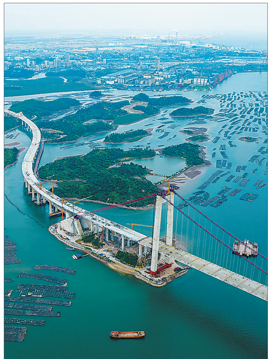
龙门大桥项目是广西首座千米级跨海悬索桥,桥梁总长6597米,主航道桥可满足2万吨级船只通航要求。大桥建成通车后,将为市民出行提供更多便利,助力北部湾经济区高质量发展和西部陆海新通道建设。
