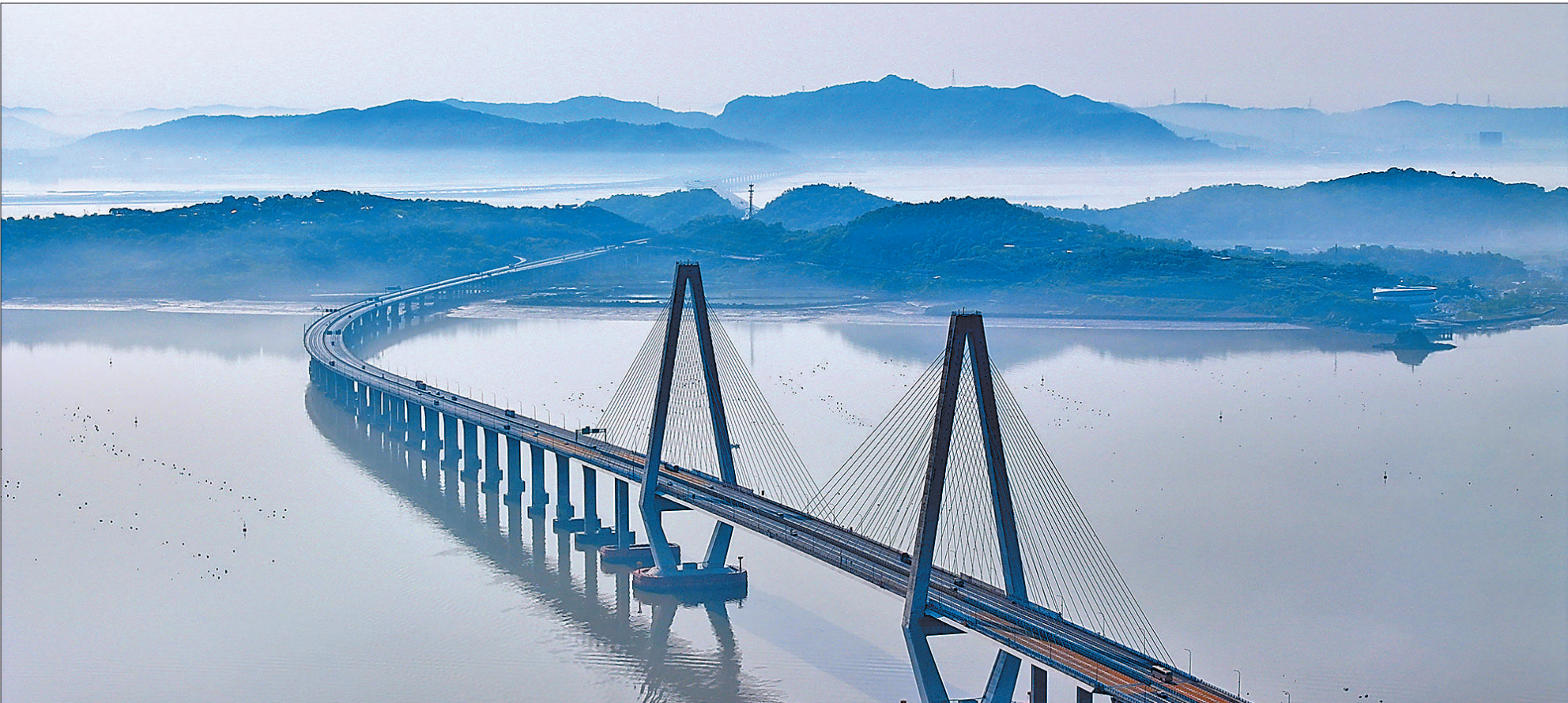
近年来,浙江省玉环市持续推进城乡交通路网建设,提升公路技术等级和安全通行水平,在方便群众出行的同时,有力地带动了农副产品流通和乡村旅游发展,推进乡村全面振兴。图为车辆在玉环市G1523甬莞高速乐清湾跨海大桥上。
