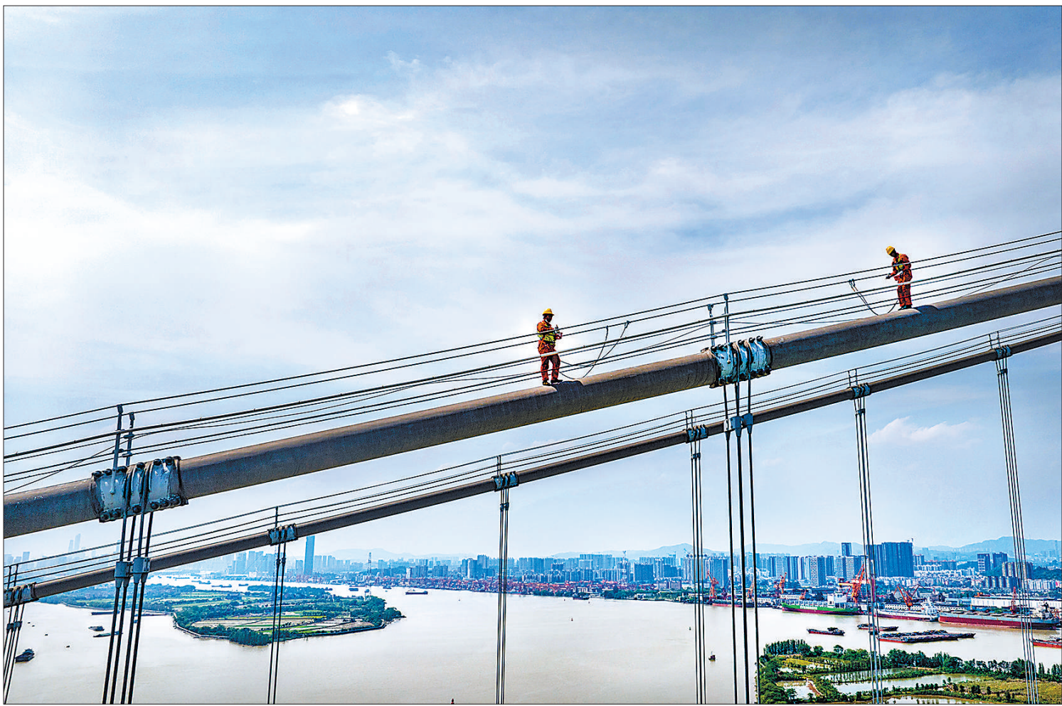
4月16日,广州黄埔大桥工作人员开展悬索桥主缆索夹螺栓紧固和主缆检修涂漆防腐作业。该桥全长7016.5米,是广东省特大型桥梁与隧道建设的重大成果。 陈志强摄(影像中国)
