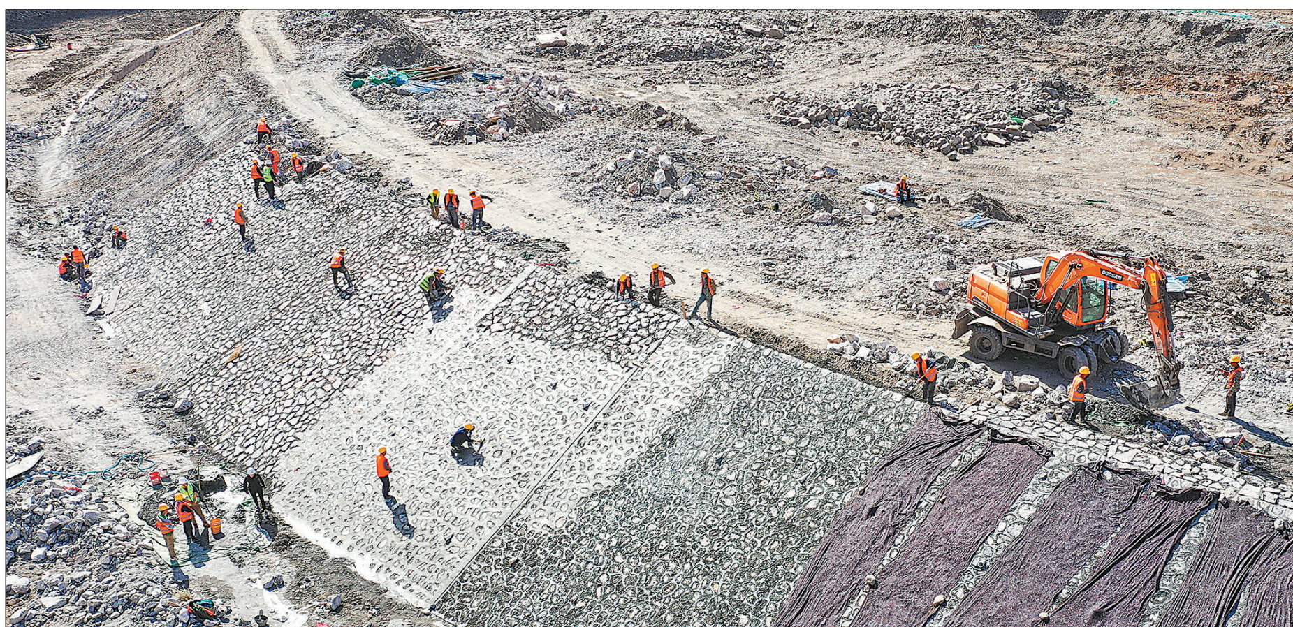
北京市房山区大石河(堂上—口头村)水毁修复工程河北镇桩木港大桥段施工现场，工人们正在进行浆砌石护砌和砂浆勾缝施工作业。近来，房山区水务领域灾后修复加快推进，已完成任务量的近八成。 刘帅治摄(人民视觉)
