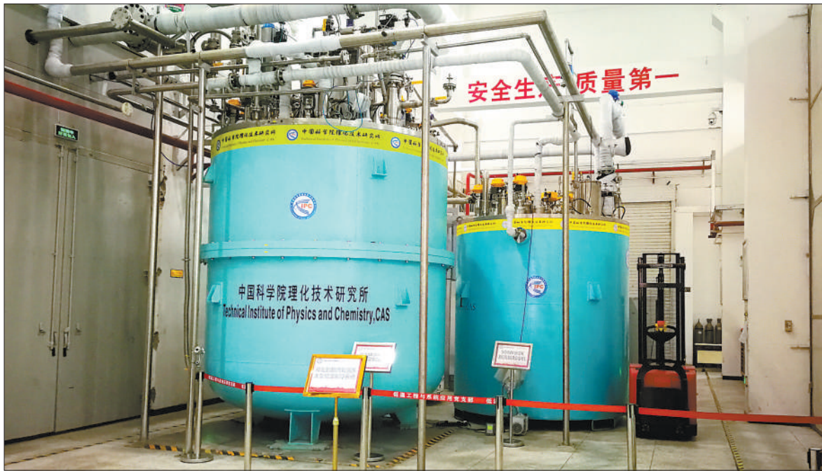
中国科学院理化技术研究所研制的液氦到超流氦温区大型低温制冷装备。中国科学院理化技术研究所供图
