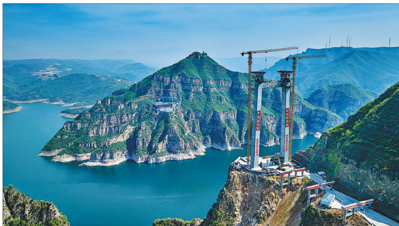
4月11日,济(源)新(安)高速公路控制性工程——济新黄河三峡大桥主体作业正在加紧推进。大桥位于河南济源市、新安县交界处的王屋山—黛眉山世界地质公园。大桥主跨510米,横跨黄河小浪底库区。 史家民摄(人民视觉)
