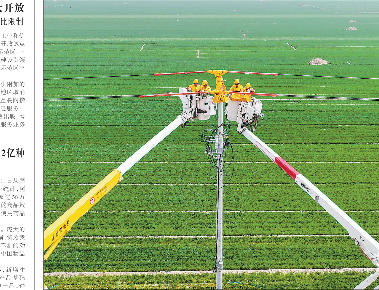
近日，在山东省菏泽市鄄城县阚镇，电力工作人员开展带电作业。春耕时节，鄄城县供电部门加强电力检修维护，为居民生产生活提供安全稳定的保障。 聂蓬摄（人民视觉）
