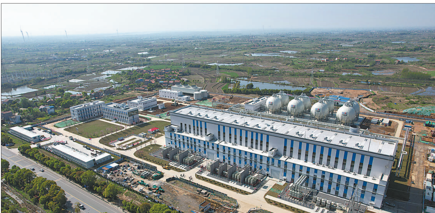
湖北应城300兆瓦级压缩空气储能电站并网发电
