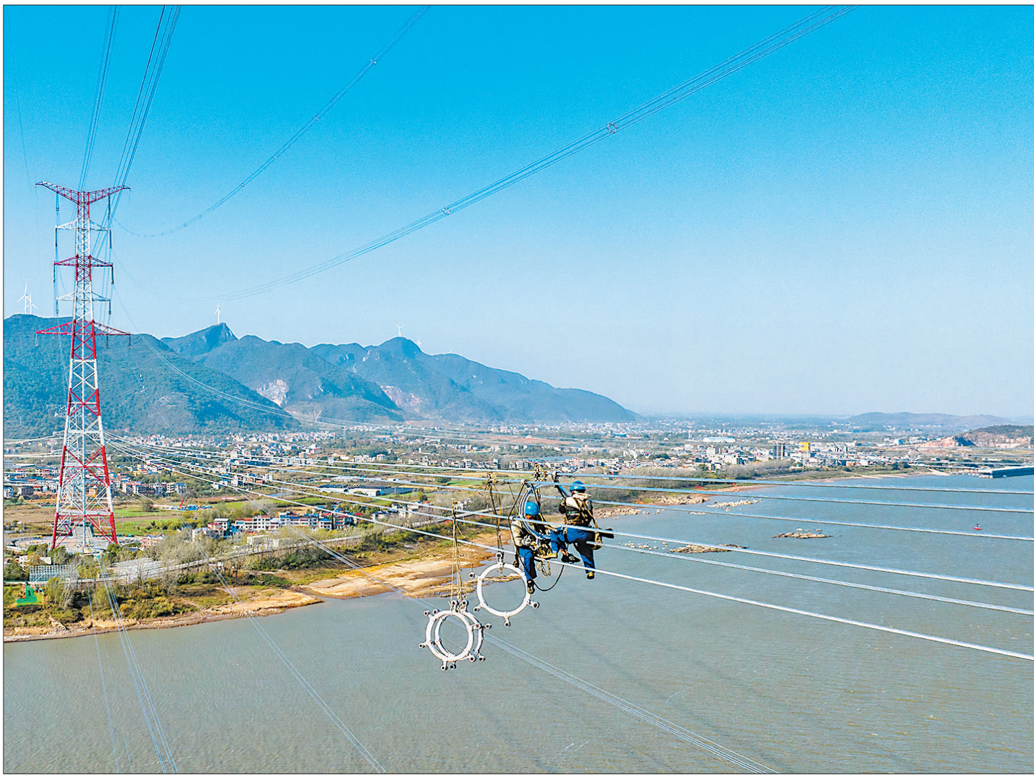
近日,在湖北省黄冈市蕲春县,技术人员在湖北武汉—江西南昌1000千伏特高压交流线路工程跨长江线路施工。
