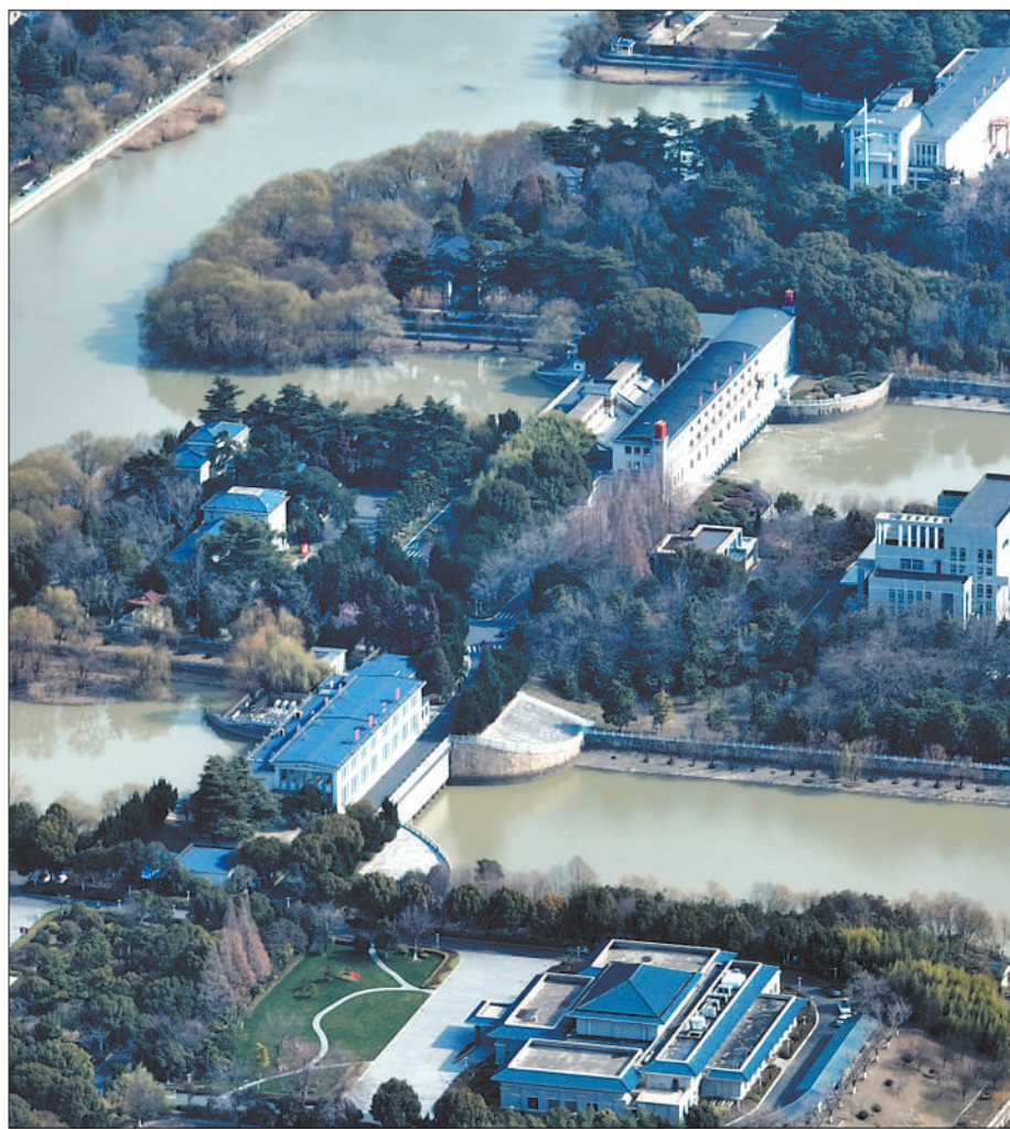
江苏扬州江都水利枢纽是南水北调东线工程的源头。图为江都水利枢纽局部。 孟德龙摄(影像中国)
