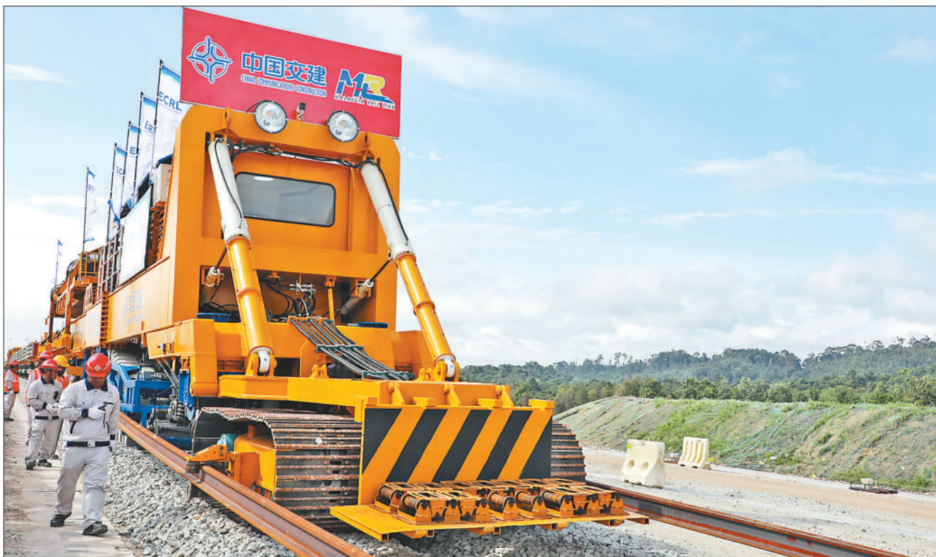
上图:在马来西亚彭亨州关丹市马东铁项目现场,铺轨机正在作业。
