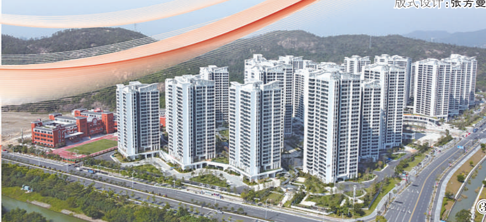
图③:横琴“澳门新街坊”项目楼群。陈康摄(影像中国)
