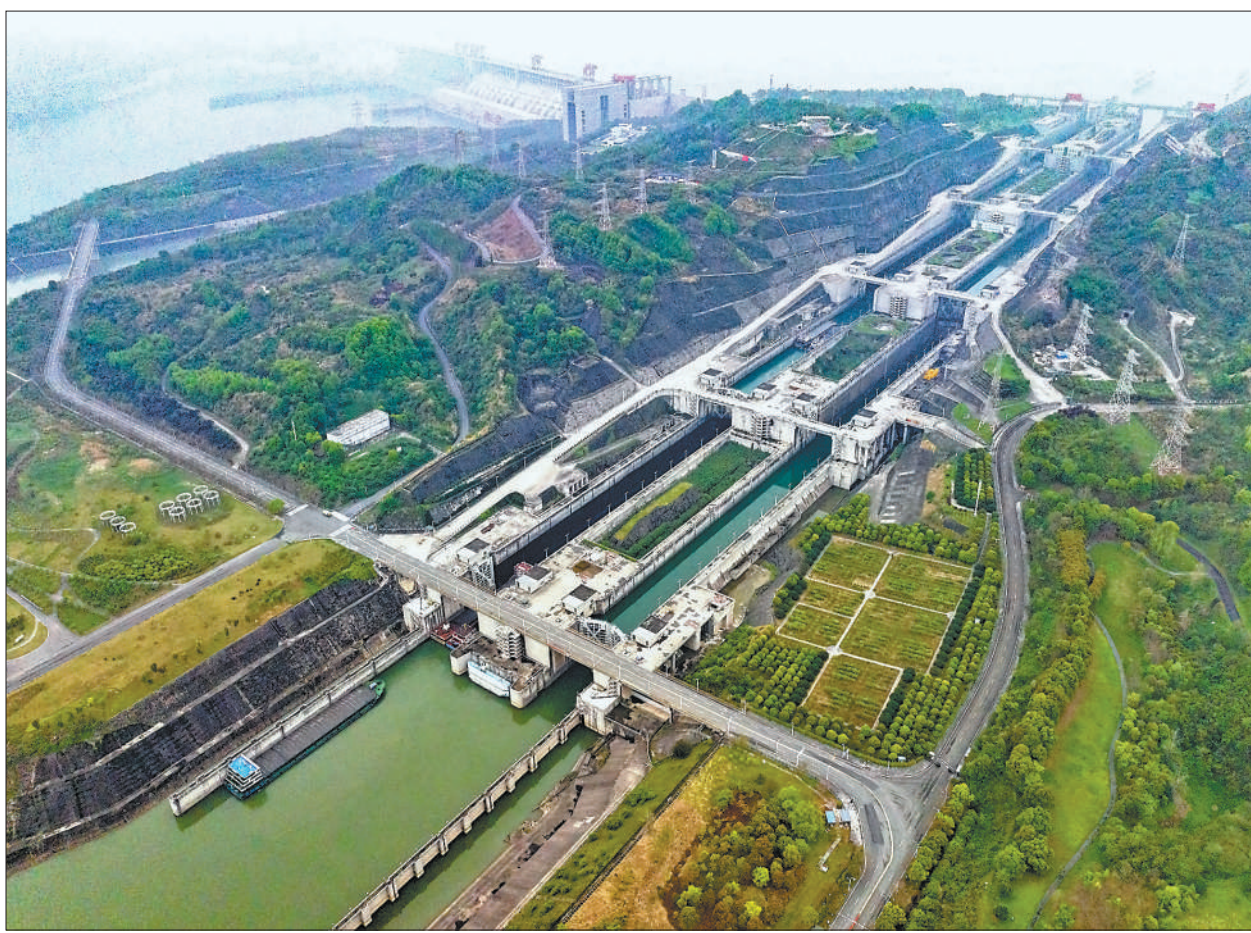
中国三峡集团4月3日发布消息，三峡船闸一季度货运量突破3000万吨，接近通航初期2004年全年的货运量。图为4月4日，过坝船舶正在有序通过五级船闸。
