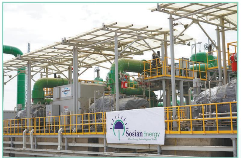
▲由中国企业承建的肯尼亚索西安地热电站于去年6月底投产送电,成为非洲首个从设计、产品生产到建设、调试完全由中国企业独立完成的地热发电站。该电站设计装机容量35兆瓦,每年可减少二氧化碳排放24万吨。图为索西安地热电站2号发电机组。本报记者 黄炜鑫摄
