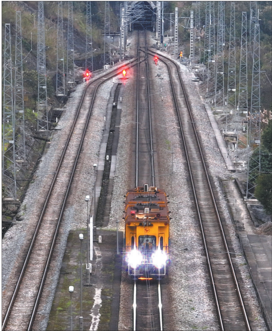
广西柳州市三江侗族自治县老堡火车站，铁路工人驾驶车辆对焦柳铁路进行线路打磨施工。
