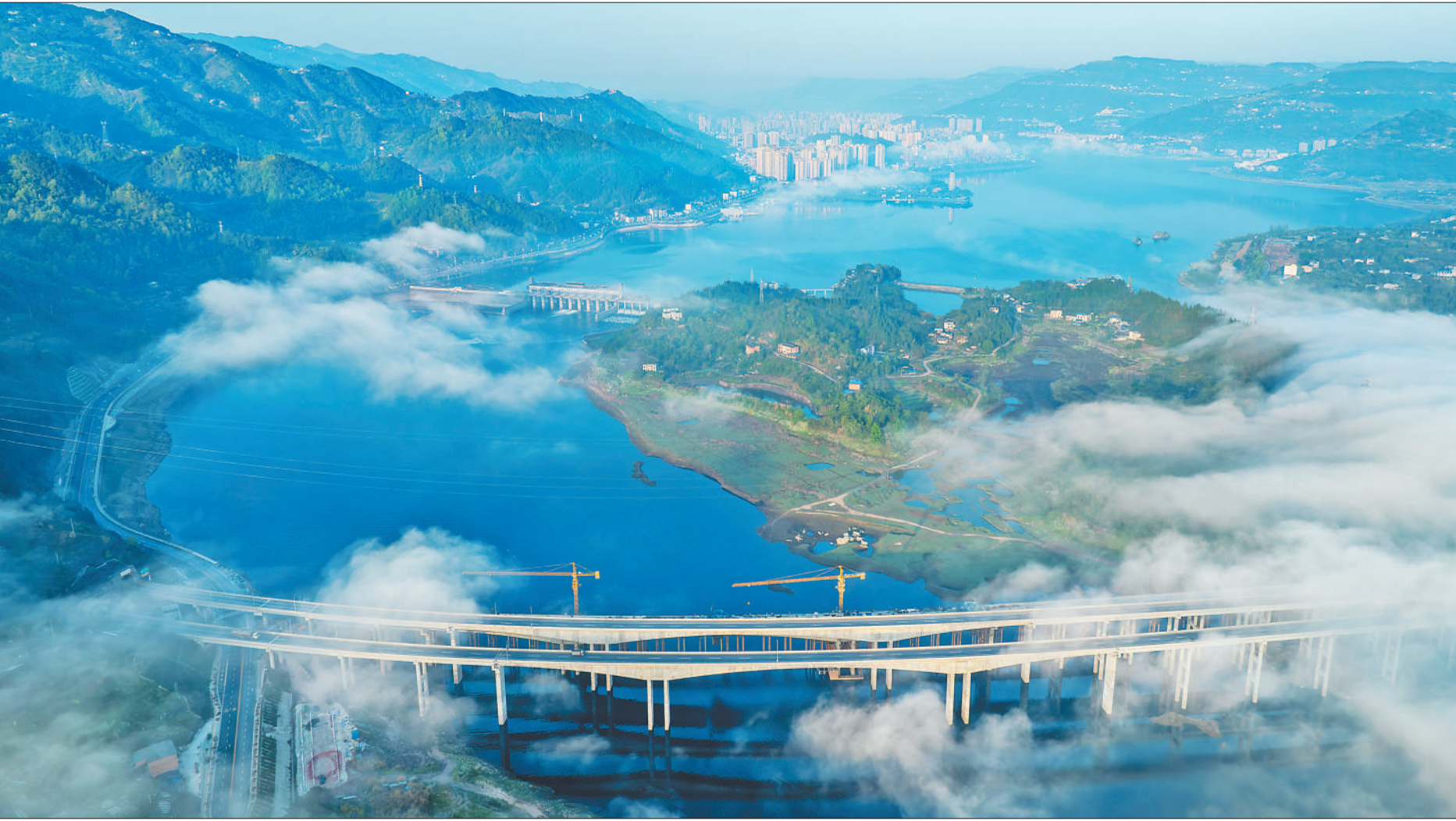
3月29日拍摄的重庆市开州区澎溪河特大桥。近年来，开州区大力推进交通基础设施建设，不断优化城乡交通路网布局，构建起以高铁高速为骨架、国道省道为支撑、县乡公路为脉络的综合交通运输体系，方便群众出行，助力经济社会发展。
