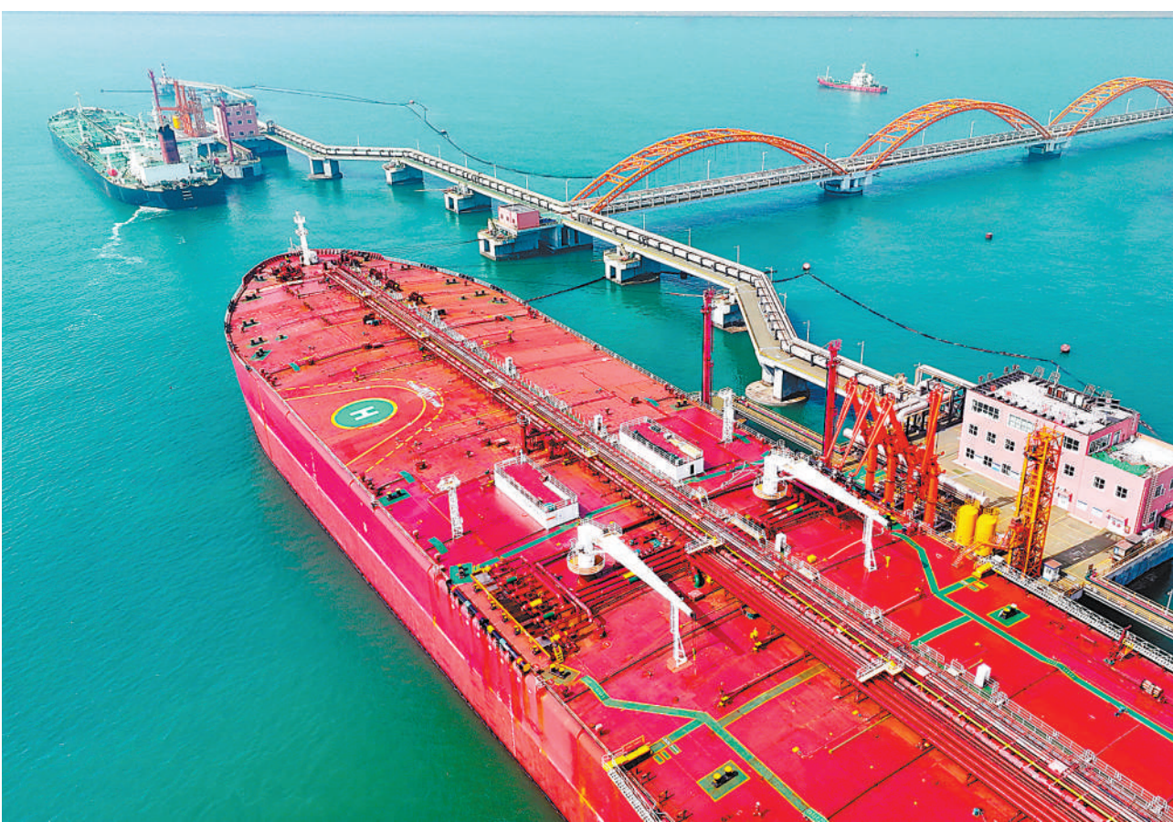
近年来，山东港口日照港发挥联动陆海、衔接南北的区位优势，着力提高港口原油运输接卸能力，目前已建成4座30万吨级原油码头。今年前两月，日照港口业务完成吞吐量1403万吨，同比增长7.5%。图为3月29日，船舶停靠日照港岚山港区进行卸油作业。
