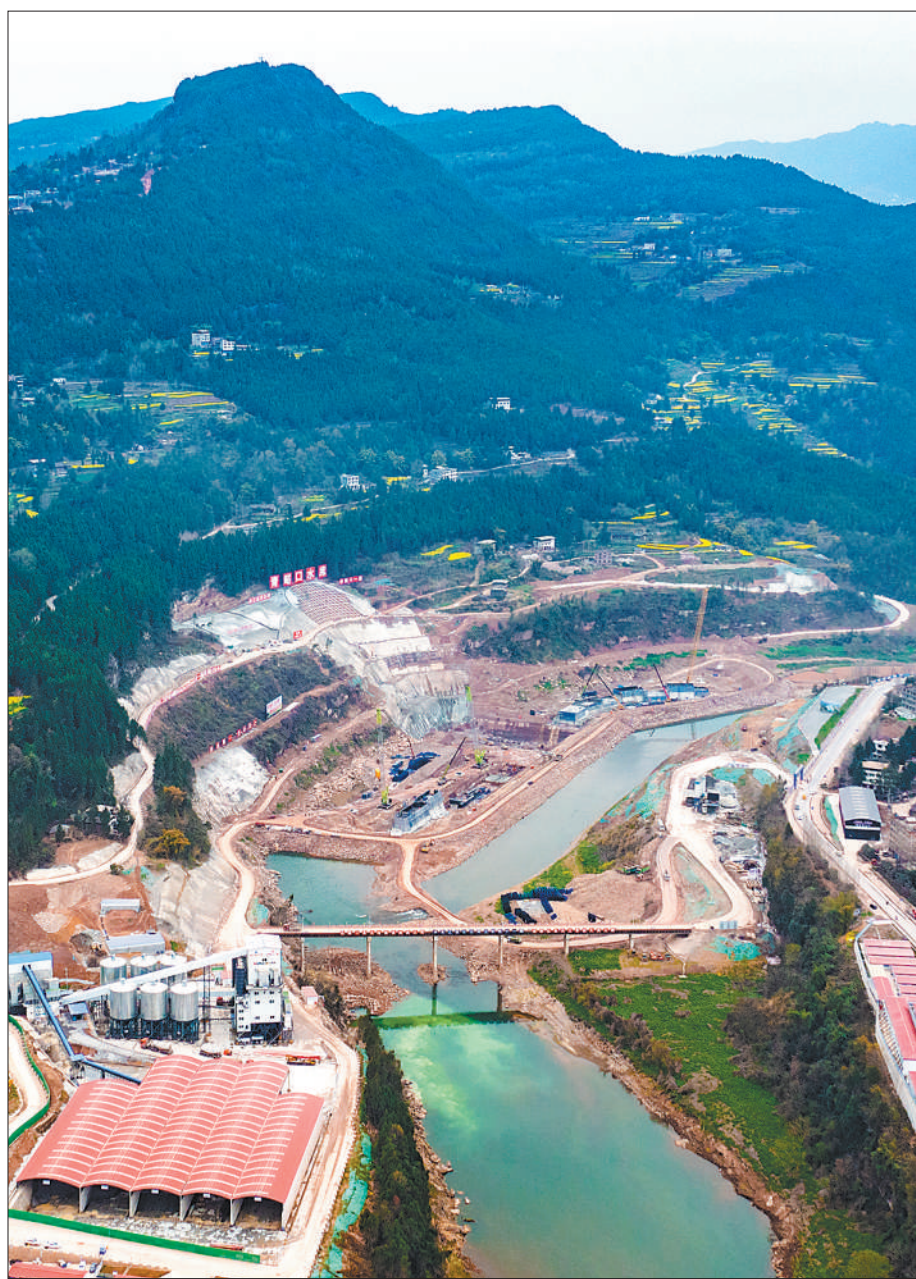
四川省巴中市通江县青峪口水库是国家150项重大水利工程之一。图为青峪口水库建设现场。
