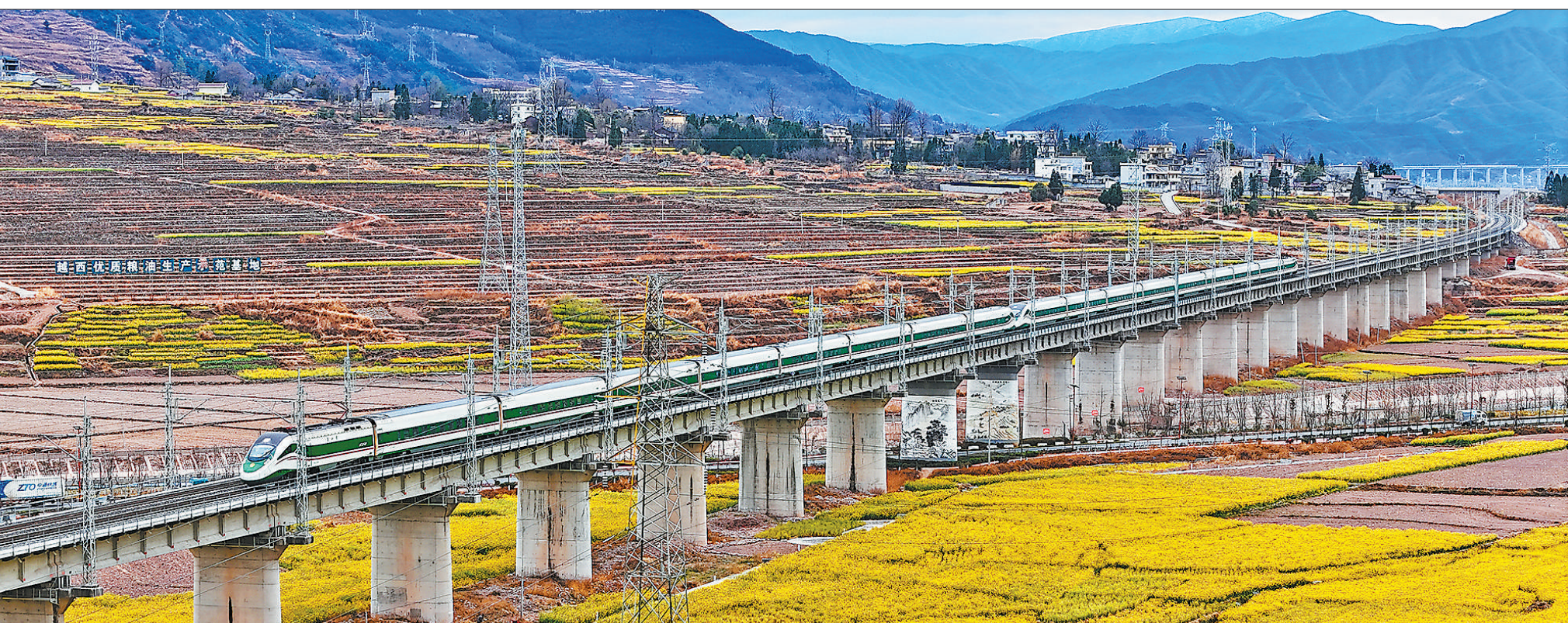
新成昆铁路自开通以来，日均开行40余趟旅客列车，单日最高发送旅客超10万人次，极大便利了四川凉山地区群众出行和货物运输，带动沿线资源开发。图为近日，新成昆铁路上一列复兴号动车组驶过四川凉山彝族自治州越西县的油菜花田。
