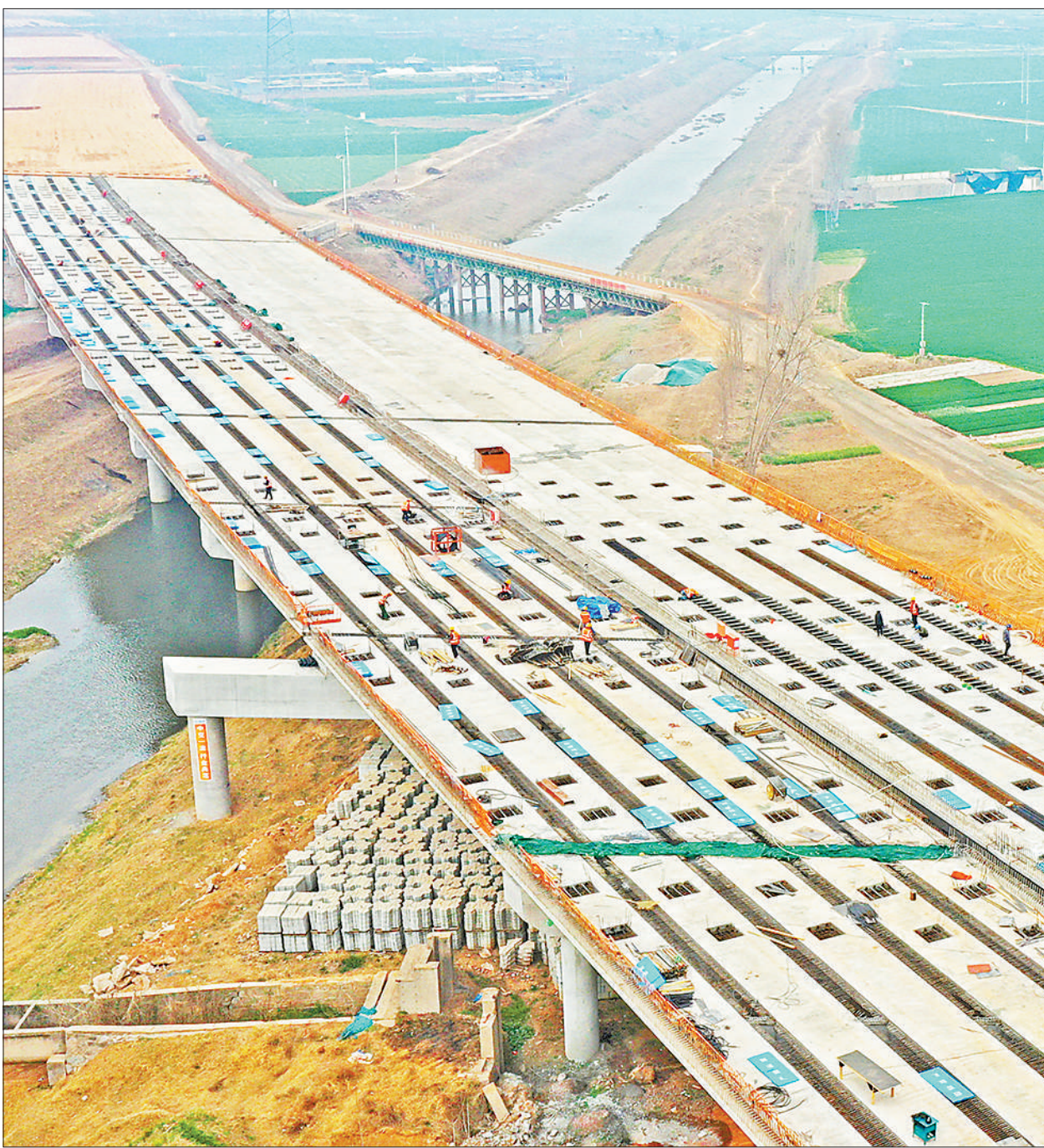
3月22日，河南省沿黄高速公路孟州市赵庄蟒改河工区，施工单位正加快工程建设进度。该项目是河南省高速公路重点工程，建成后将助力完善中原高速公路网结构。
