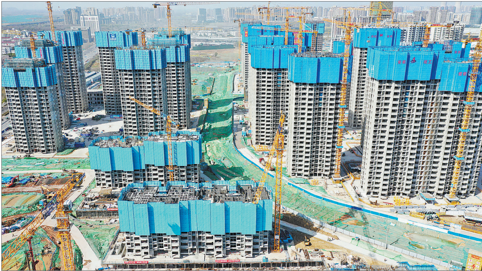
连日来,安徽省合肥市蜀山区新站片区安置房项目建设稳步、有序推进。该项目所有楼栋今年将全面封顶,可实现万余人的安居梦。图为3月21日项目施工现场。陈三虎摄(影像中国)
