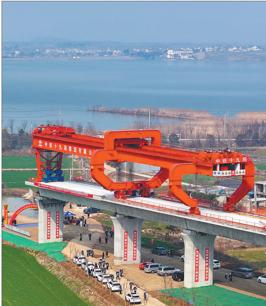
沪渝蓉高铁建成后,将串联起长三角城市群、长江中游城市群和成渝双城经济圈。图为沪渝蓉高铁南京段架设首根箱梁。
