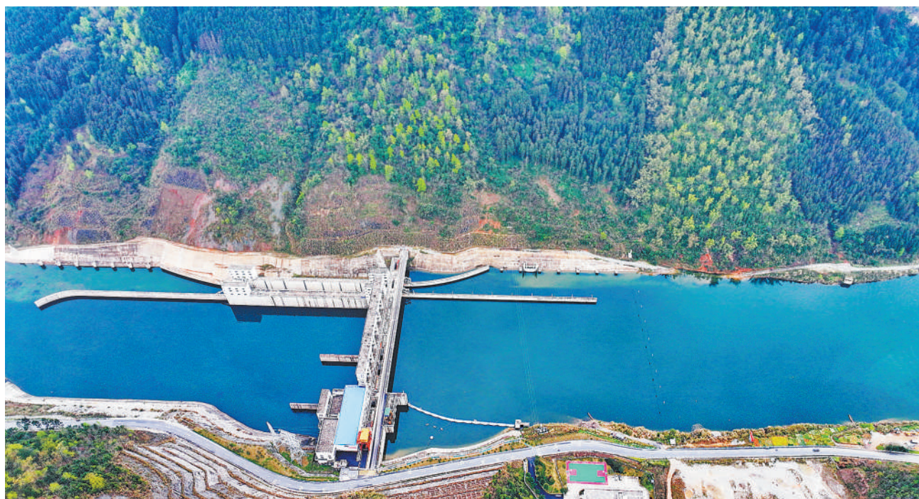
贵州省黔东南苗族侗族自治州从江县积极构建清洁低碳的能源供给体系,建成多座航电枢纽工程,助力当地绿色发展。图为从江县温寨航电枢纽。
