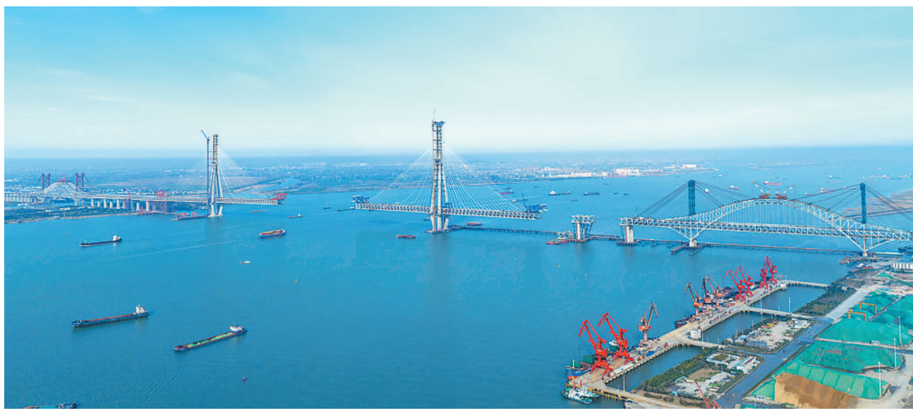
常泰长江大桥是长江经济带综合立体交通走廊的重要项目。大桥连接江苏省常州市与泰州市,是一座集高速公路、城际铁路和普通公路为一体的过江通道。图为3月13日泰州泰兴市常泰长江大桥主航道桥的施工现场。赵振宇摄(影像中国)
