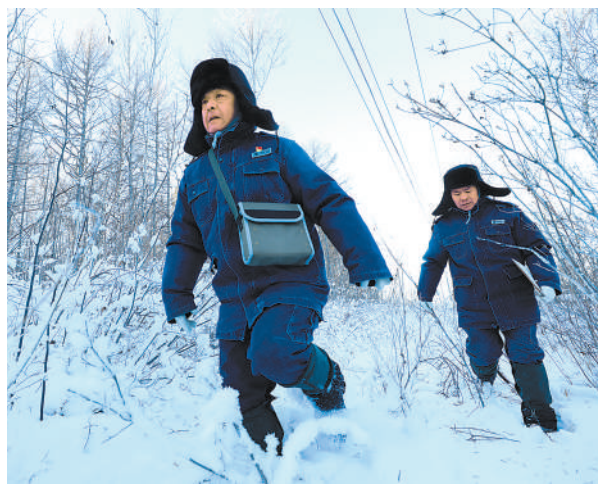
吕建生(左)冒雪巡检10千伏配电线路。赵稼丰摄(人民视觉)
