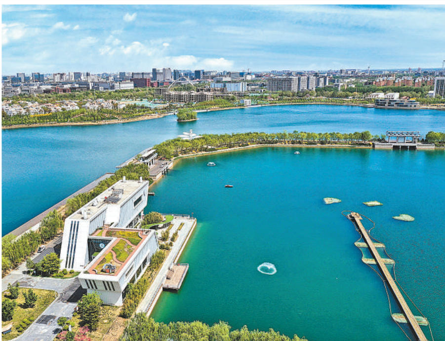
▲南水北调北京段重要配套工程——亦庄调节池二期项目投用以来，亦庄调节池水面面积在原有12.4公顷的基础上再增加42公顷，不仅大大提升南水北调供水保障率，也进一步擦亮城市生态底色。图为亦庄调节池。 本报记者 贺勇摄
