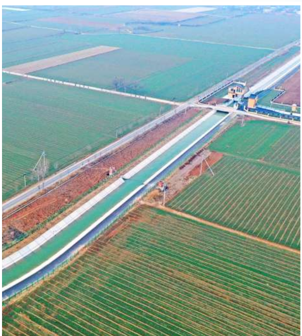
▲黄河小浪底北岸灌区工程是国家节水供水重大水利工程，也是河南构建黄河流域“一轴两翼三水”现代水网的重要组成部分。图为竣工投用的小浪底北岸灌区及配套工程河南孟州片区赵和镇西冶村段。 白水平摄(影像中国)
