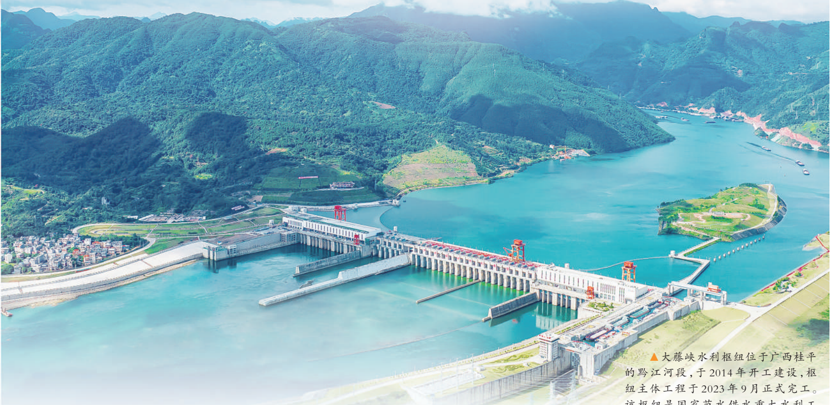
▲国家节水供水重大水利工程——引汉济渭工程于2023年7月实现先期通水。从长江最大支流汉江引来的江水，穿过近百公里的秦岭输水隧洞后，最终补给黄河最大支流渭河。图为位于陕西汉中的引汉济渭工程主水源地黄金峡水利枢纽。 刘正根摄(影像中国)
