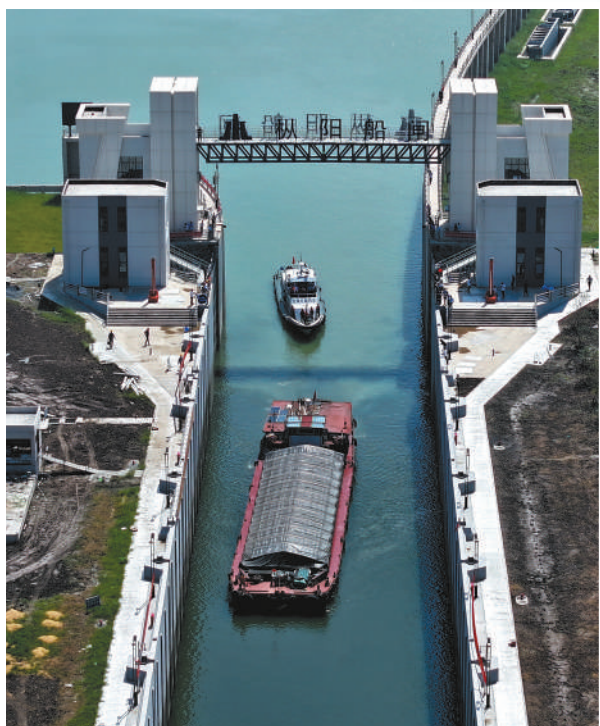
▲位于安徽的引江济淮工程枞阳小港及菜子湖线航道2023年9月开启试运行。图为货船驶过菜子湖线枞阳船闸。 王世保摄(人民视觉)
