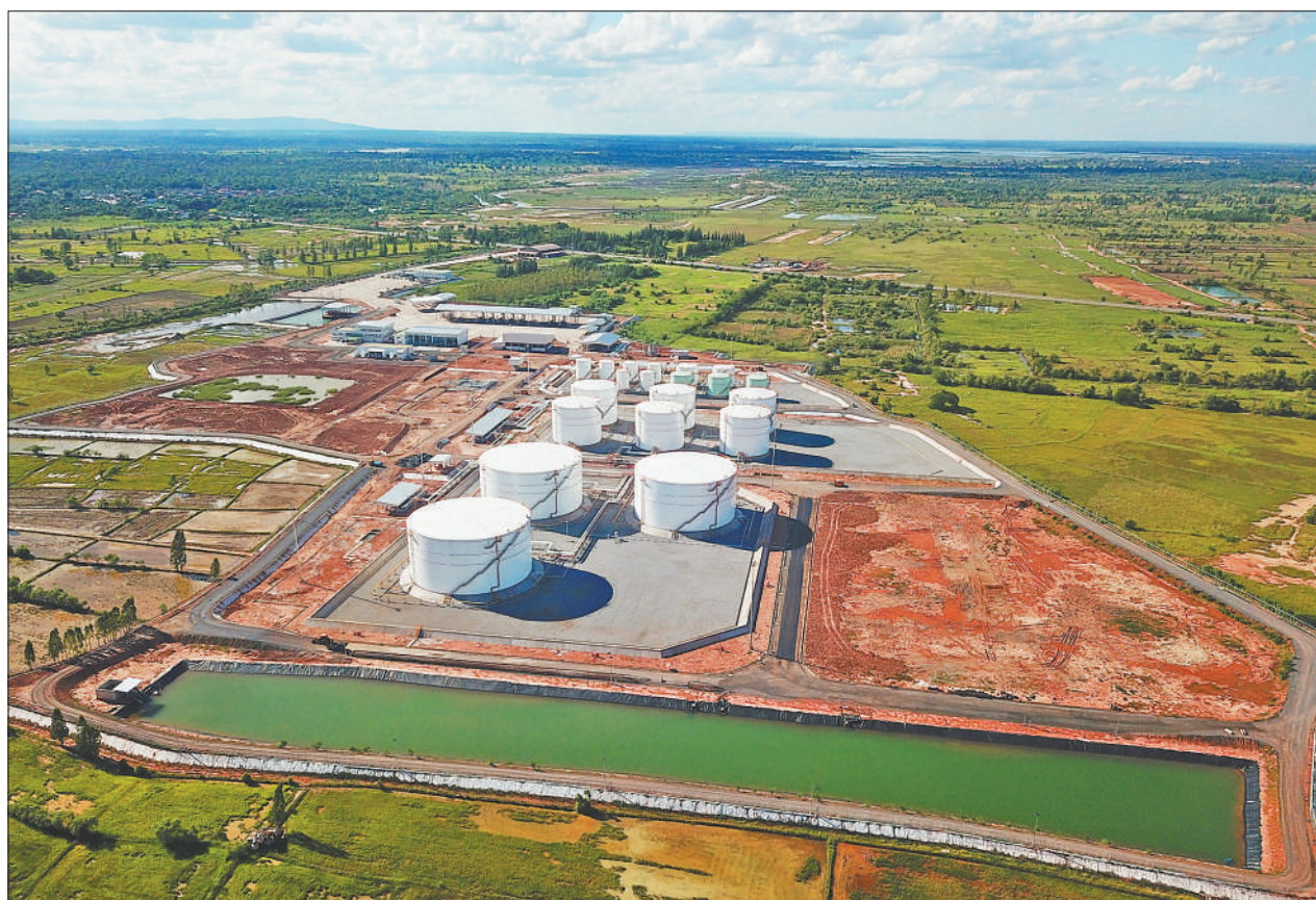
泰国东北部成品油管道工程罐区终端全景。
